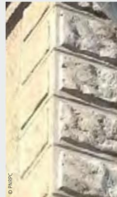
Décor en stuc d'une chaîne d'angle imitation pierre avec la technique du bosselage.
