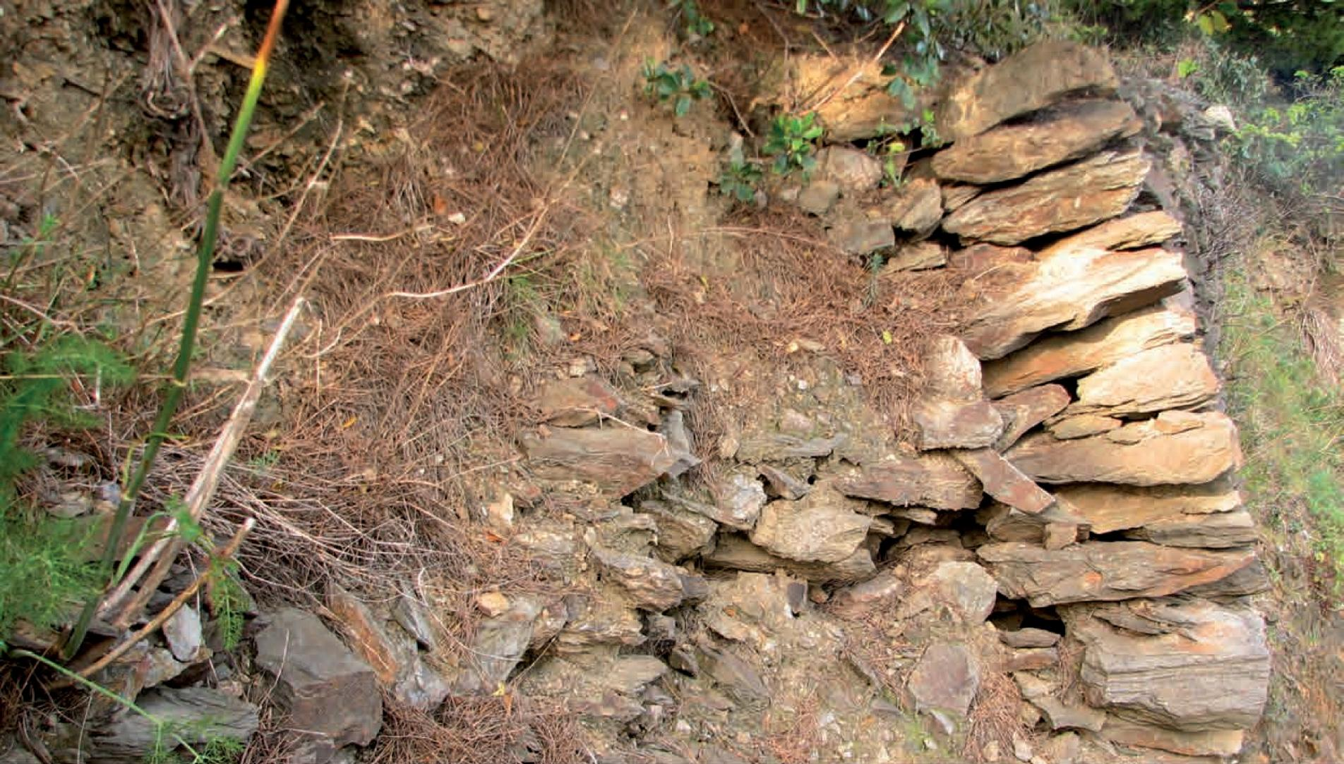
Murette effondrée : la partie du mur encore en place fait ventre, le parement s'est désolidarisé de l'arrière du mur (replomb)
