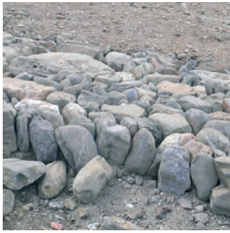
Empedrat en cours de pose : les pierres sont posées verticalement, de manière jointive
