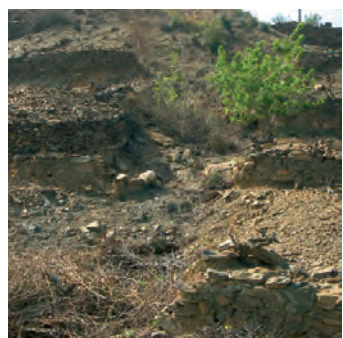
L'eau s'est créé un chemin à travers les terrasses de la parcelle. Afin d'éviter que l'érosion ne s'amplifie, il faudrait envisager de réaliser une agulla suivant l'itinéraire tracé par le ruissellement de l'eau.
